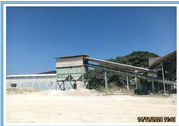
รูปที่ 3-17 สายพานลำเลียงแบบปิดคลุม
